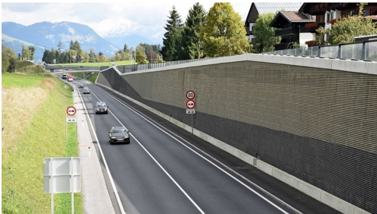
Bild 2: Trassenabsenkung, Blickrichtung Lofer, Lärmschutzwände und -verkleidungen
