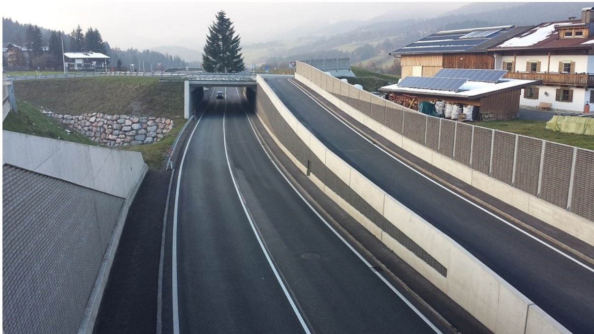
Bild 1: Trassenabsenkung, Blickrichtung Wörgl, Lärmschutzwände und -verkleidungen
