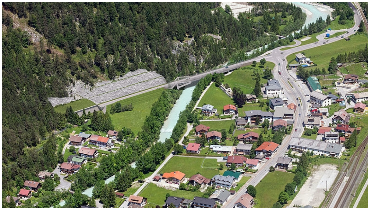
Bild 4: Knoten Scharnitz Nord, Tunnelportal Nord und Isarbrücke mit baulichem Lärmschutz
