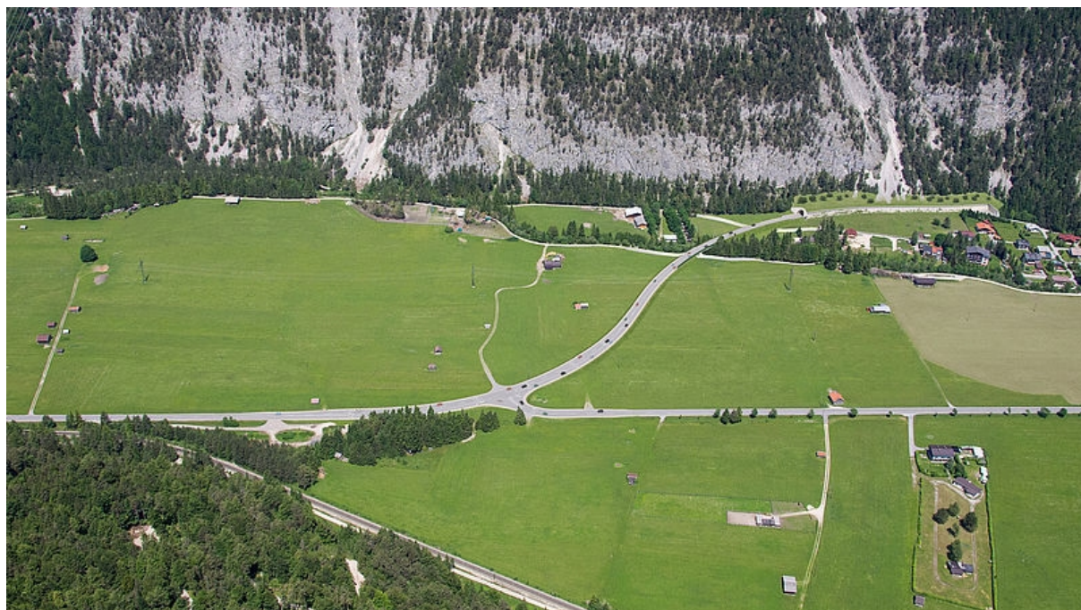
Bild 3: Knoten Scharnitz Süd, Tunnelportal Süd mit baulichem Lärmschutz
